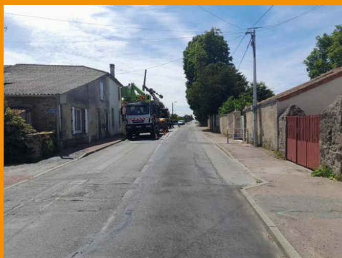
Travaux d'enfouissement rue du Calvaire
