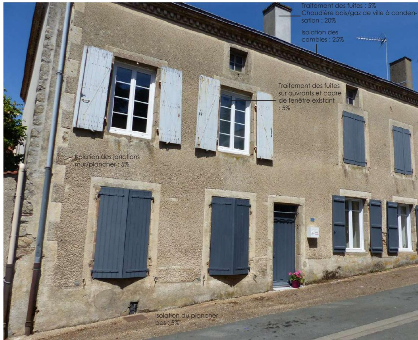
*Hypothèse A : isolation de la toiture, des planchers, et traitement des fuites d'air (menuiseries anciennes non jointives, cheminées non fermées, percements des façades, cave etc) par calfeutrement simple et bonne calibration d'une VMC existante pour contrôler le renouvellement de l'air : économie de 47%*
