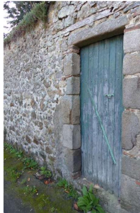
Un mur de clôture en moellons de granite rejointoyés
