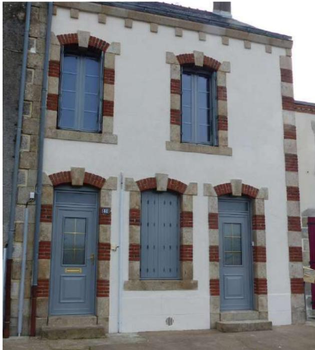
Façade en moellons enduits ; encadrements, corniche et chaînages en granite et brique
