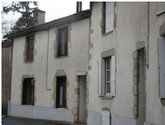
Encadrements des ouvertures en granite apparent
